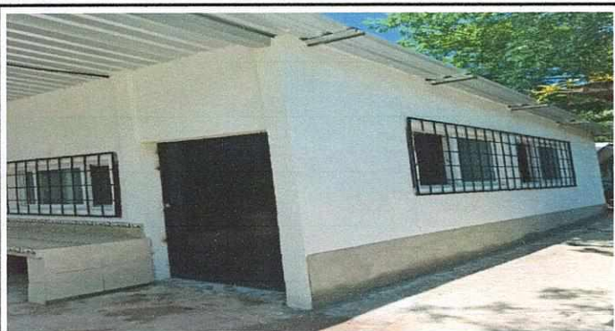
Foto 3: Módulo cocina: Mejoramiento, ampliación de paredes e instalación de puerta y valcones. culminada
