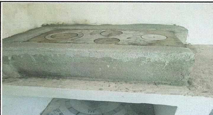
Foto 4: Módulo cocina: Sustitución y mejoramiento de plancha de cocina culminada.
