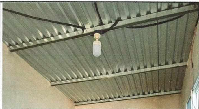
Foto 1: Módulo cocina: sustitución de lamina en mal estado por lámina troquelada calibre 26 e instalación electrica culminada.
