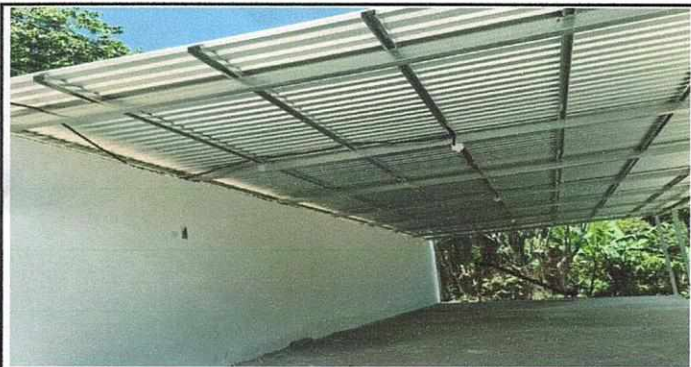
Foto 9: Módulo anexo a aula: Reparación ampliación de paredes e instalación de luz electrica. Culminada.
