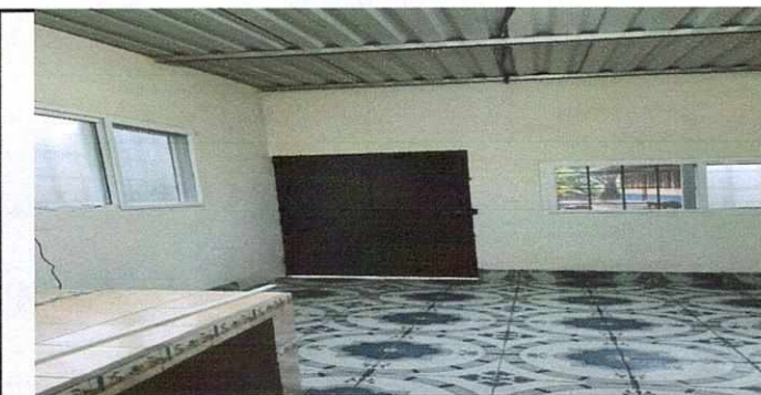
Foto 5: Módulo cocina: Sustitución de torta de cemento por piso cerámico en cocina. Finalizada.
