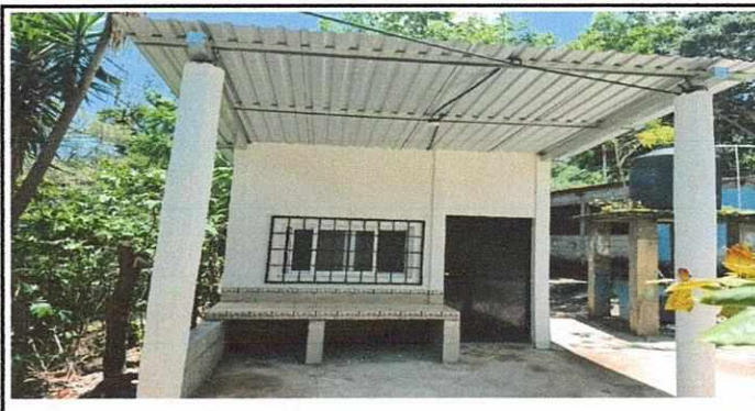
Foto 2: Módulo cocina Sustitución de estructura de madera dañada por estructura metálica galvanizada culminada.
