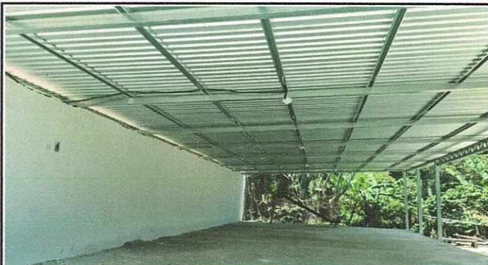
Foto 7: Módulo anexo a aula: Instalación de techo con estructura galvanizada. Culminada.
