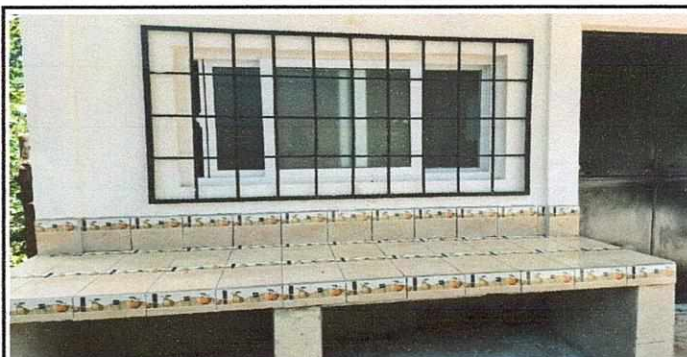
Foto 6: Modulo cocina: Ampliación y mejoramiento mesa de cocina por piso de azulejo . Finalizada.
