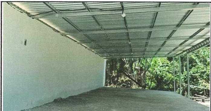
Foto 10: Módulo anexo a aula: Reparación de espacio de torta de cemento y repello de paredes culminada.
