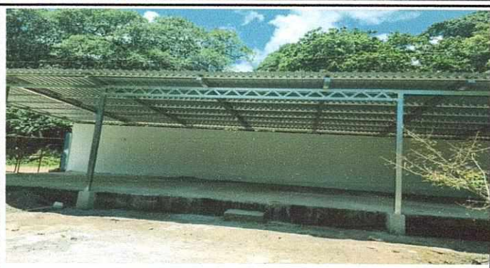
Foto 8: Módulo cocina: Instalación de techo con estructura galvanizada con lamina Maxalum calibre 26 culminada.
