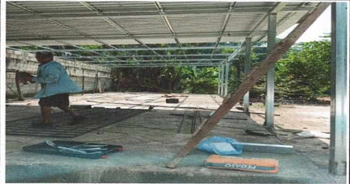
Foto 8: Proceso de Instalación de techo con estructura galvanizada lamina Maxalum calibre 26 troquelada. Módulo anexo a aula.
