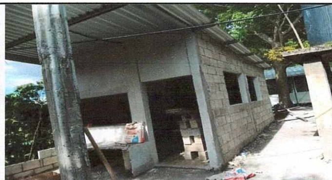
Foto 3: Módulo cocina: Mejoramiento y ampliación de paredes en proceso.
