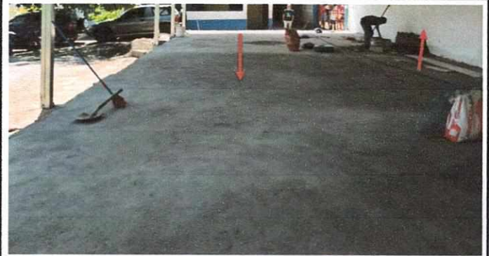
Foto 10: Módulo anexo a aula: Reparación de espacio de torta de cemento y repello de paredes en proceso.
