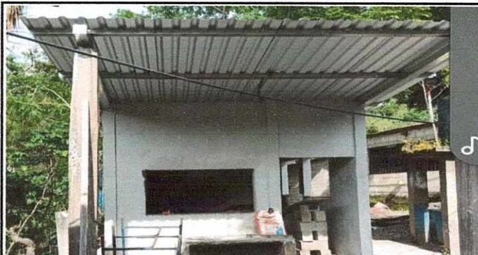
Foto 2: Módulo cocina: Sustitución de estructura de madera dañada por estructura metálica galvanizada en proceso.
