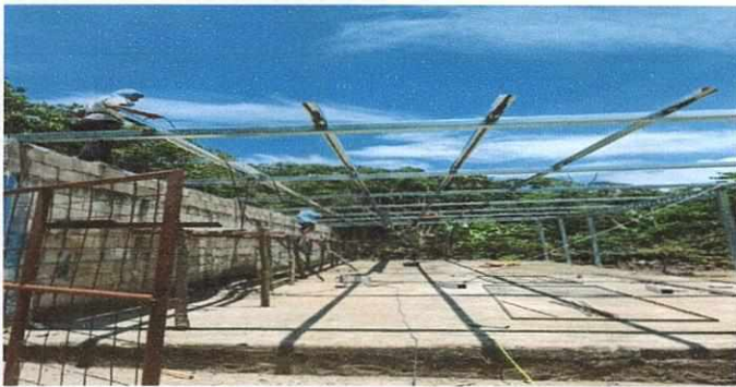
Foto7: Módulo anexo a aula: Instalación de techo con estructura galvanizada en proceso.
