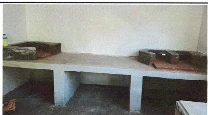
Foto 4: Módulo Cocina: Sustitución y mejoramiento de plancha de cocina en proceso.
