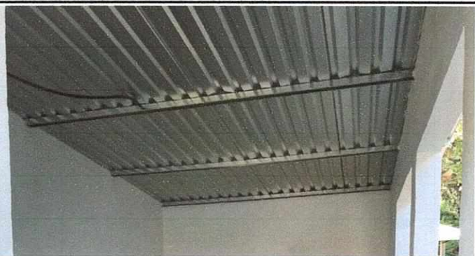
Foto 1: Módulo cocina sustitución de lamina en mal estado por lámina troquelada calibre 26 en proceso.
