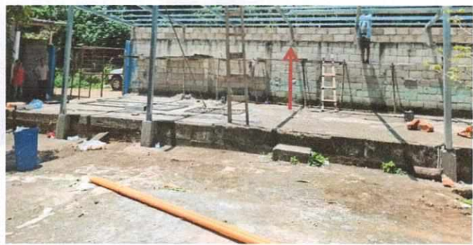
Foto 9: Módulo anexo a aula: Proceso de reparación y ampliación de paredes
