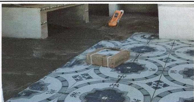
Foto 5: Módulo cocina: proceso de Sustitución de torta de cemento por piso cerámico en cocina en proceso.
