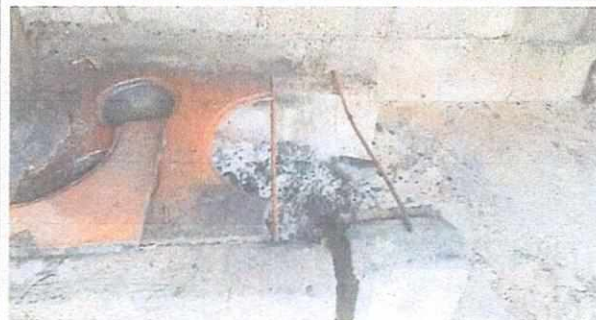
Foto No 8 Sustitución y mejoramiento de plancha de cocina
