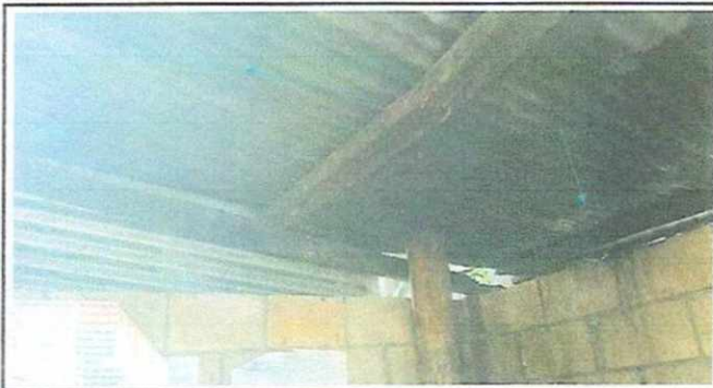
Foto No 1. Sustrución de lámina en mal estado por lámina troquelada calibre 26 modulo cocina
