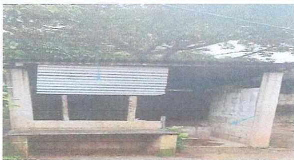
Foto No 7 Instalación de puerta y ventana módulo cocina
