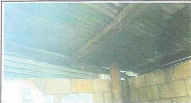
Foto No 1: Sustitución de lámina en mal estado por lámina troquelada calibre 26 modulo cocina
