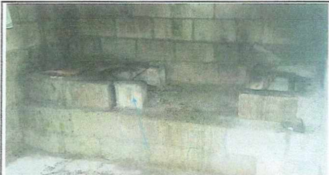
Foto NO 4: Sustitución y mejoramiento de plancha de cocina
