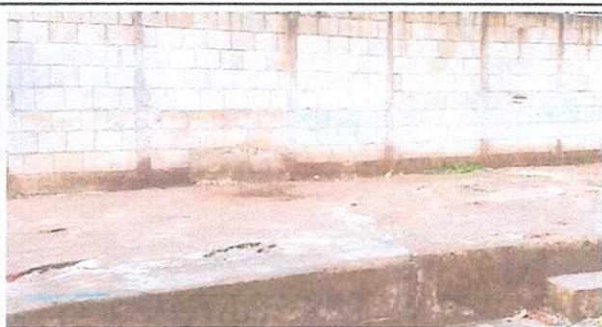
Foto No 9: Ampliación y seguimiento de área anexa a aulas
