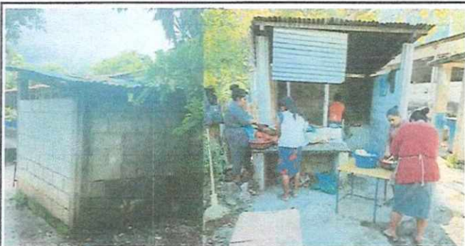
Foto No 3: Modulo cocina mejoramiento y ampliación de paredes
