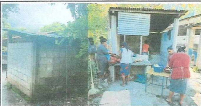
Foto No 3: Modulo cocina mejoramiento y ampliación de paredes
