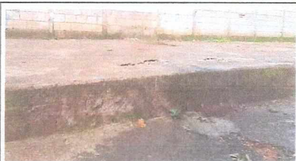
Foto No 10: Reparación de espacio de torta de cemento del área anexa a aulas
