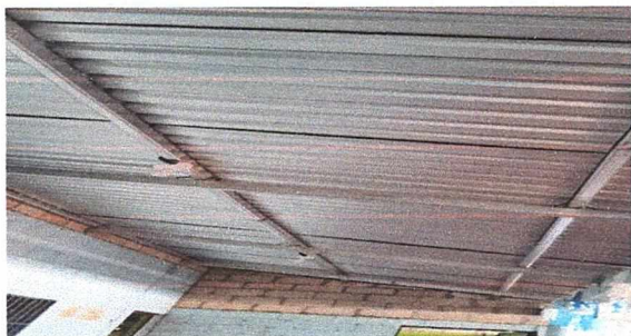
Foto1: Sustrucción de lámina dañada por lamina troquelada calibre 26
