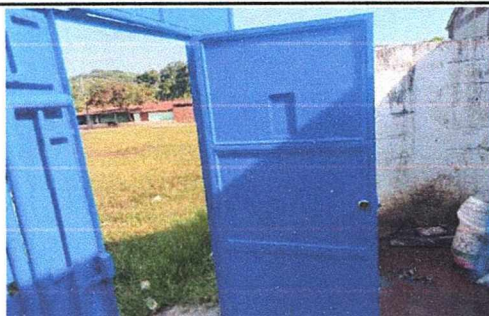
Foto 5: Reparación y mantenimiento de porton agregandole una puerta de acceso directo
