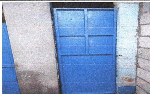
Foto 4: Reparación de puerta metálica dañadas, renovación y pintura
