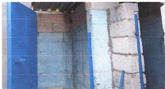
Foto 2: ampliacion de pareded de modulo sanitario con block
