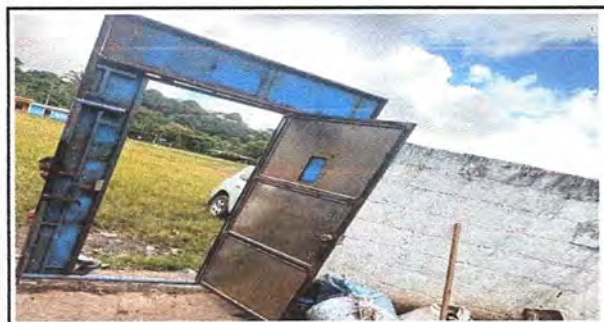
Foto 5: Reparación y mantenimiento de porton agregandole una puerta de acceso directo
