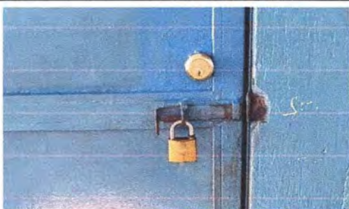
Foto 5: sustitución de chapa de puertas metalica
