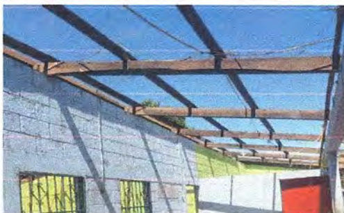
Foto1: Sustrución de lámina dañada por lamina troquelada calibre 26
