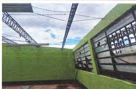
Foto 2: Sustrución de lámina dañada por lamina troquelada calibre 26 de aulas
