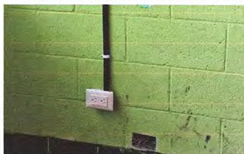
Foto 4: Instalación de red electrica tomacorrientes
