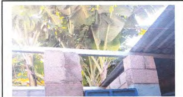
Foto 3: Susutitución y ampliación de techo modulo de sanitarios con lámina troquelada calibre 26 y estructura galvanizada
