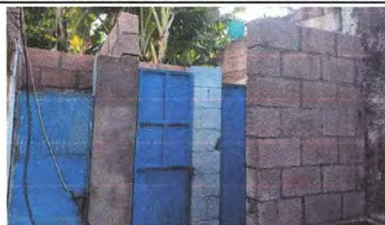
Foto 2: ampliacion de pareded de modulo sanitario con block
