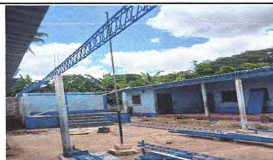
Foto 6: Reparación y ampliación de estructura metalica de una galera inter-aulas
