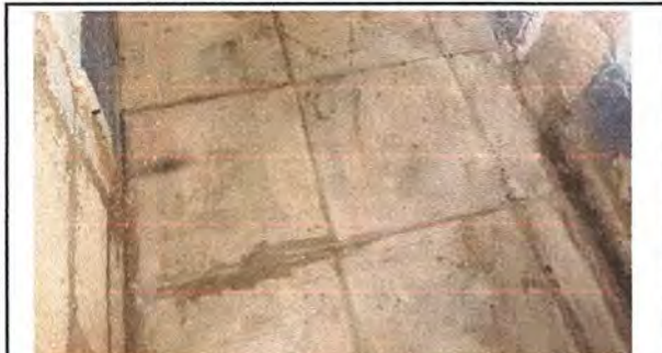
Foto1: Sustrucción de torta de cemento por piso ceramico antideslizante
