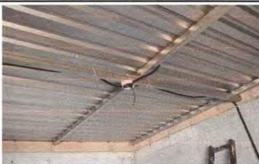
Foto 3: Instalación de red electrica bombillas
