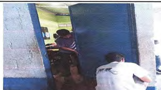
Foto 6: sustitución de puerta de madera comprimida por puerta de metal con chapa
