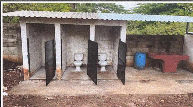
Foto 4: Inodoros, pila instalada y techo terminado de baños
