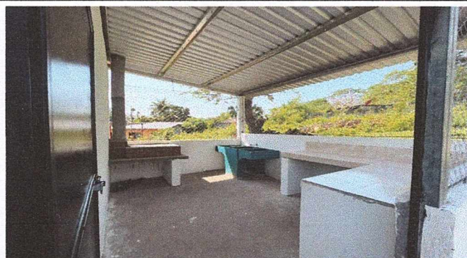
Foto 2: Interior de cocina terminada
