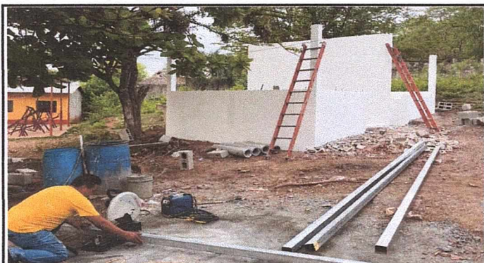
Foto 3: Repello de paredes
