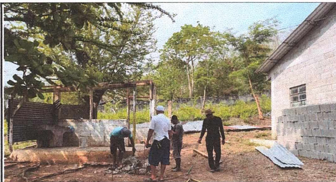
Foto 1: Inicio de la remodelacion de cocina
