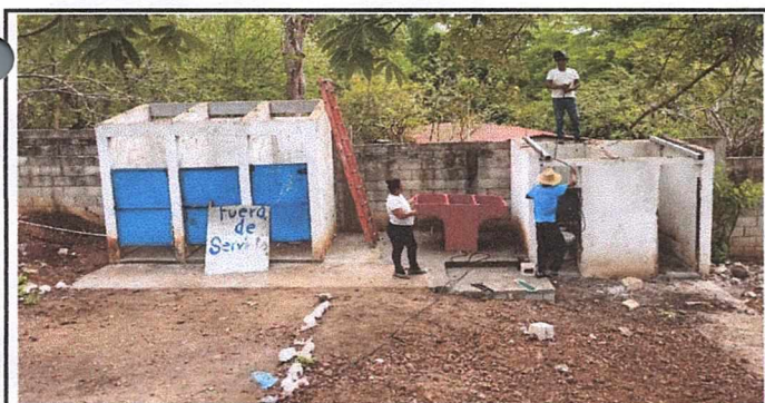
Foto 5: Instalacion de techo, inodoros y pila en baños
