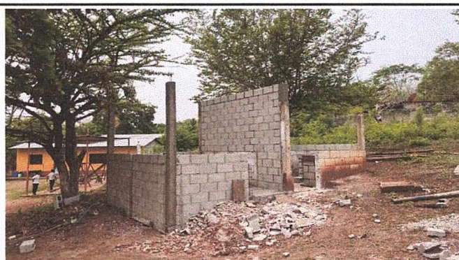
Foto 2: Levantamiento de paredes
