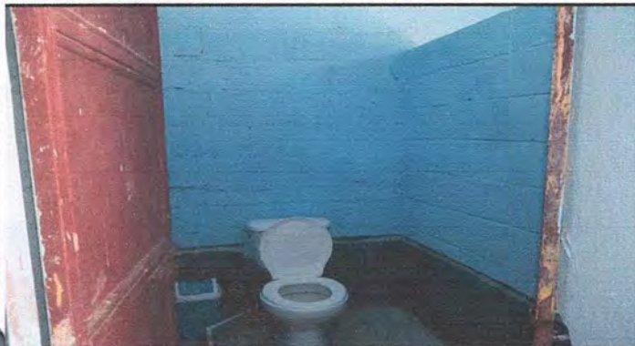
Foto1: Cambio de sanitario y piso de cemento
