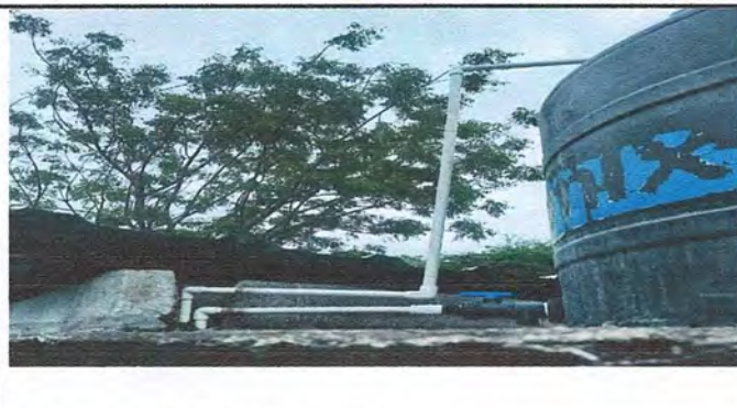
Foto 4: Cambio de tubería de ténaco o depósito de agua
