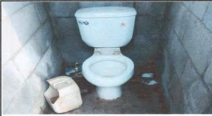
Foto 2: Cambio de accesorios a cuatro baños
