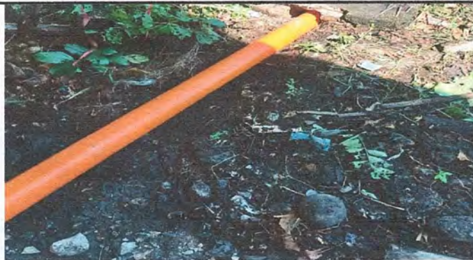
Foto1: Cambio de tubo de drenaje
