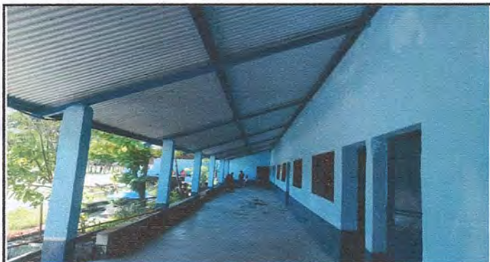
Foto 3: Cambio de techo y pintura general
