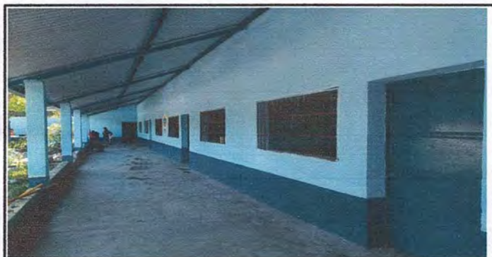
Foto 3: Pintura de dirección, 3 aulas, 2 bodegas, cocina y 2 baños
