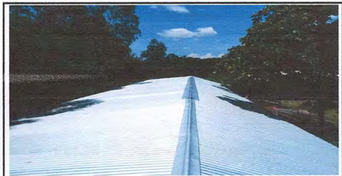
Foto 6: Cambio de techo total, laminas y costaneras
