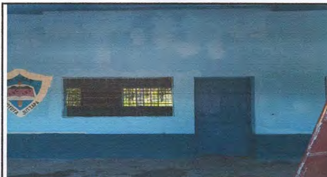
Foto 4: Pintura de dirección, 3 aulas, 2 bodegas, cocina y 2 baños
