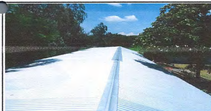
Foto 5: Cambio de techo total, laminas y costaneras
