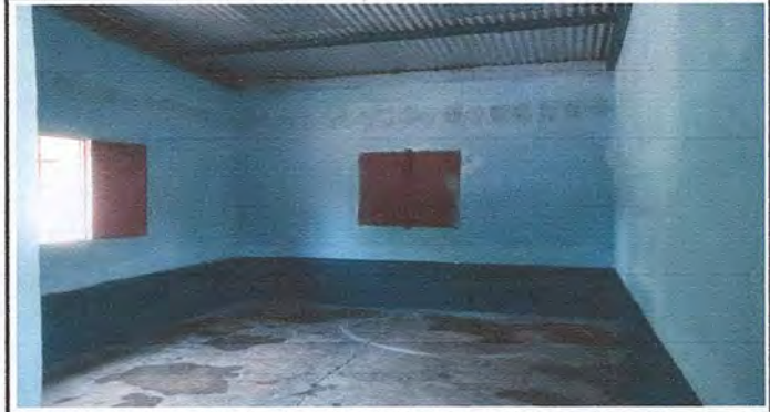
Foto 2: Pintado de aula interior, cambio de techo y puerta
