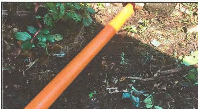
Foto 2: Instalación de tubería nueva.
