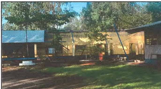
Foto 4: Cambio de costaneras en las aulas.
