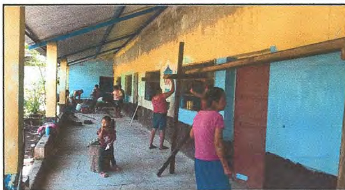
Foto 6: Pintando el exterior de las aulas.
