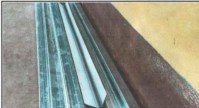
Foto 4: Materiales del techo
