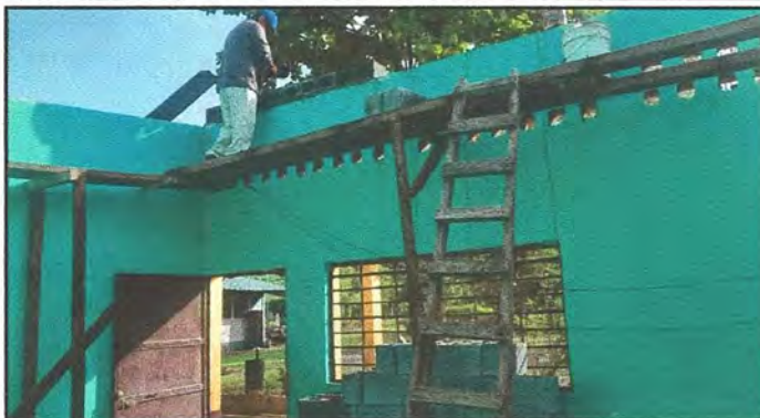
Foto 2: Preparación para instalar costaneras y láminas.
