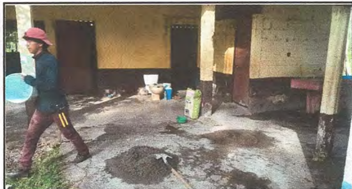
Foto 3: Preparación de materiales para colocar block.
