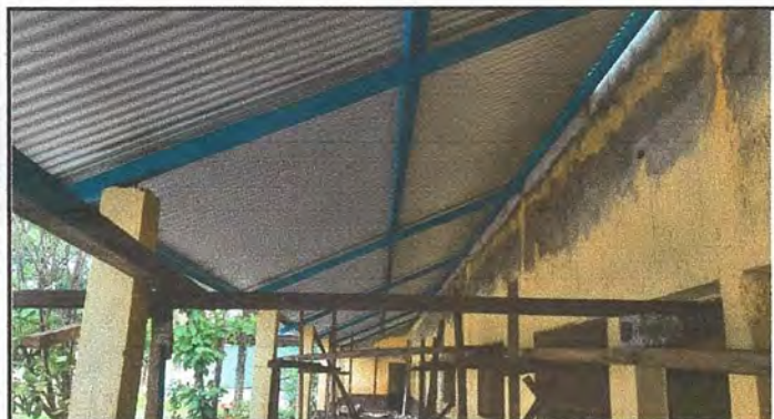
Foto 3: Cambio de lámina nuevas en pasillo y salones de clase.
