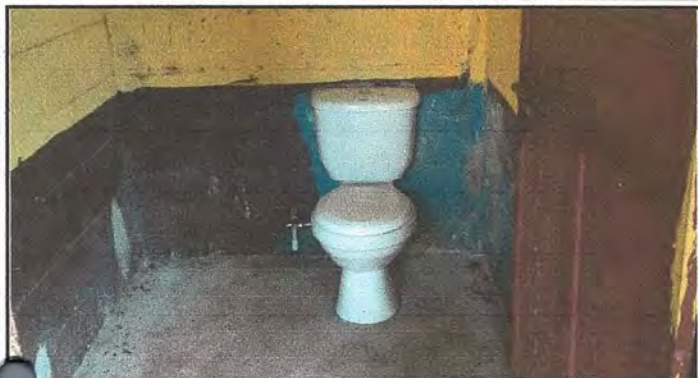
Foto1: Instalación de sanitarios nuevos y torta de cemento.
