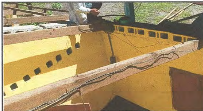
Foto 6: Cambio del techo de aulas.
