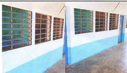
Foto 4: FABRICACIÓN E INTALACIÓN E BALCONES DE METAL
