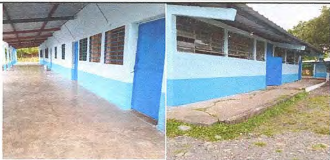
Foto1: MEJORAMIENTO DE PINTURA EXTERIOR
