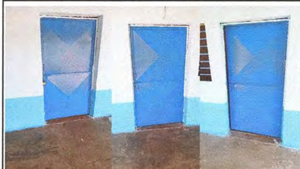
Foto 2: SUSTITUCION DE PUERTAS
