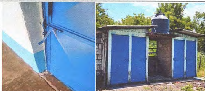
Foto 3: MANTENIMIENTO DE PUERTAS
