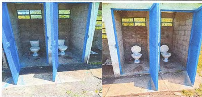
Foto1: SUSTITUCIÓN DE INODOROS Y MATENIMIENTO DE PUERTAS
