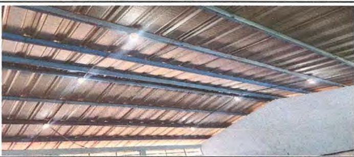
Foto 5: SUSTITUCIÓN DE PLAFONERAS
