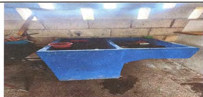
Foto 5: INSTALACIÓN DE PILA Y CHORRO
