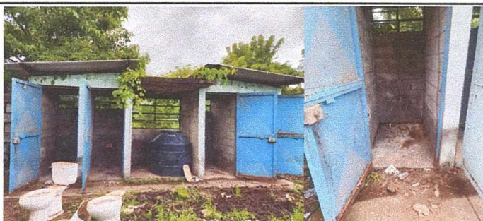
Foto 3: INSTALACIÓN DE INODOROS
