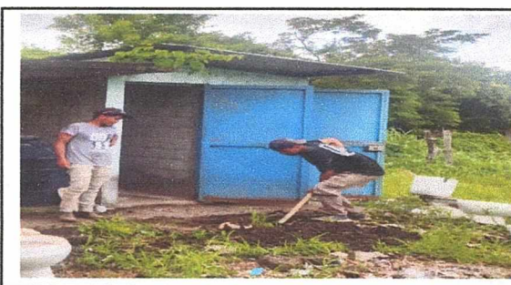
Foto 6: INSTALACION DE TUBERIA
