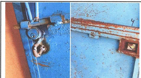
Foto 4: MANTENIMIENTO DE PUERTAS DE METAL COLOCACION DE PASADORES
