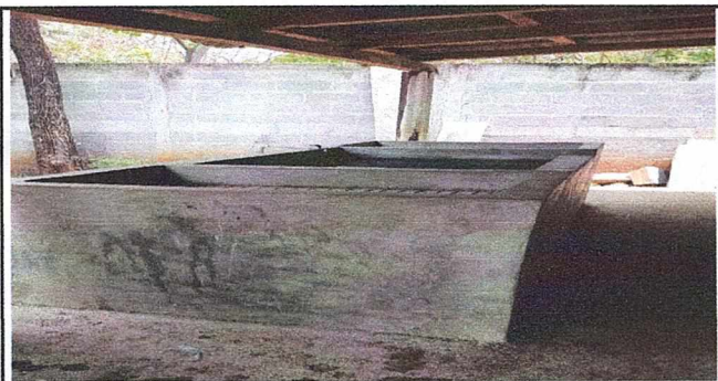
Foto 3: REMOZAMIENTO DE PILA
