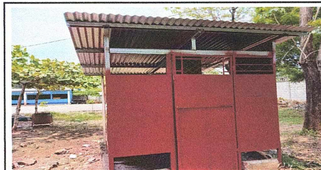
Foto 4: REPARACIÓN DE MIGITORIO (NIÑOS)
