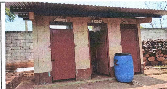
Foto 5: REPARACIÓN DE PUERTAS DE SANITARIO
