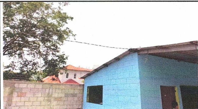
Foto 1: INSTALACIÓN DE SISTEMA ELÉCTRICO
