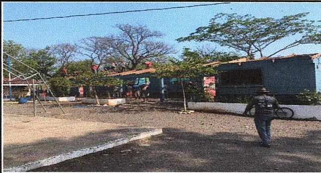
Foto 1: Padres de familia desmontando techo para ser sustituido.
