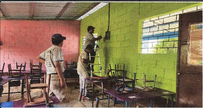
Foto 3: Instalación de energía eléctrica por personal capacitado.
