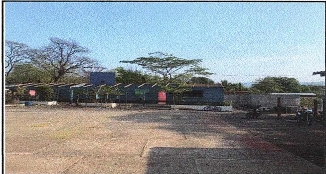
Foto 2: Quitando estructura de madera para reemplazar por estructura de metal.
