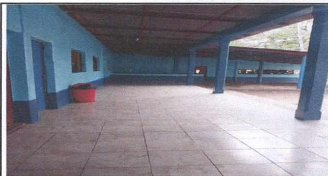
Foto 6: SUSTITUCIÓN DE PISO
