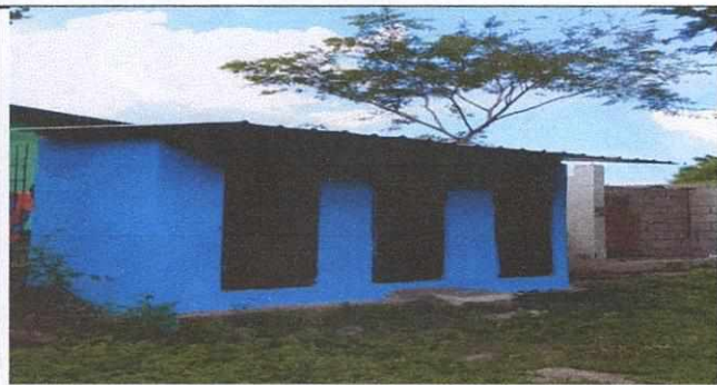
Foto 5: MEJORAMIENTO DE SANITARIOS
