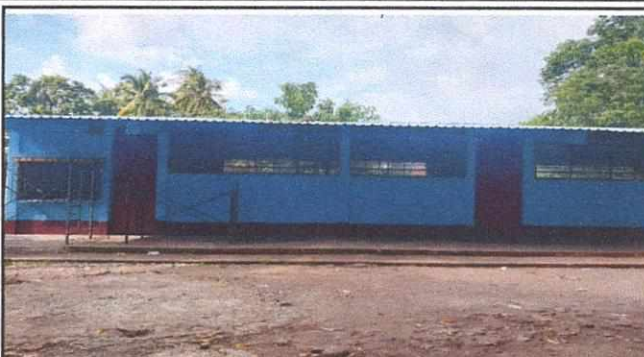
Foto 2: MEJORAMIENTO DE TECHO
