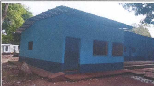
Foto 3: MEJORAMIENTO DE ESTRUCTURA Y LAMINA
