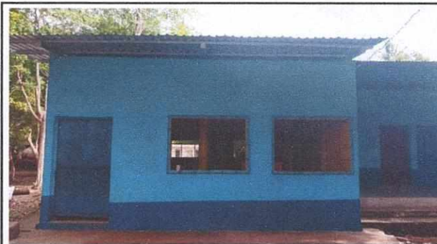
Foto 4: SUSTITUCION DE TECHO COMPLETO
