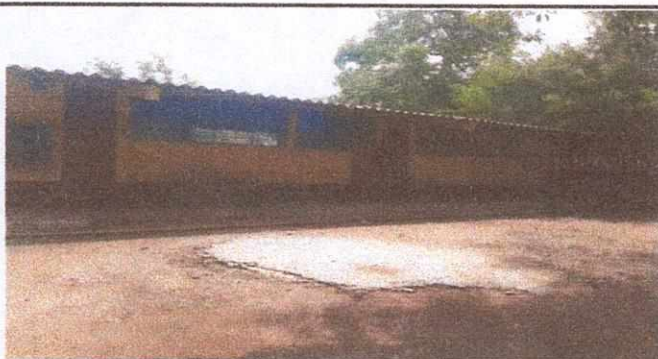
Foto 5: Sustitución de techo en mal estado
