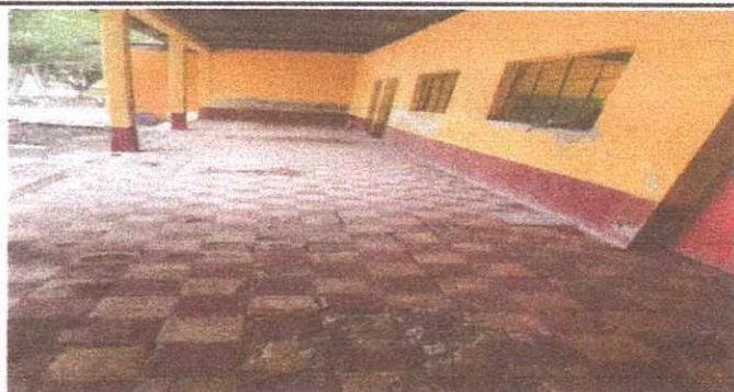
Foto 4: Sustitución de piso en mal estado por cerámico
