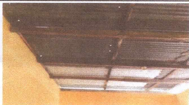
Foto 3: Sustitución de estructura de madera y lámina en mal estado
