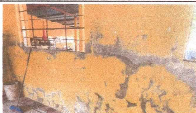
Foto 2: Mejoramiento de pared en mal estado
