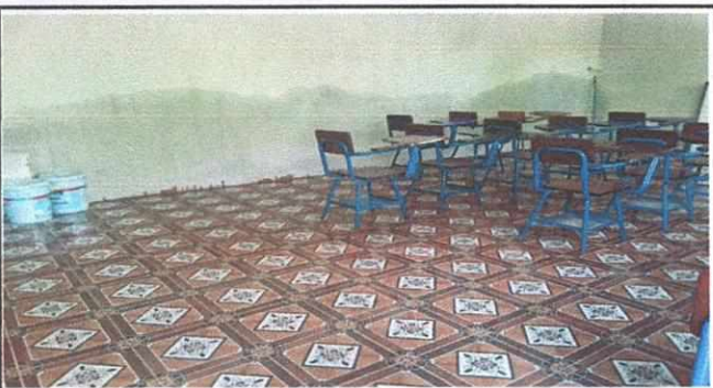
Foto 3 Piso colocado en cada uno de los salones
