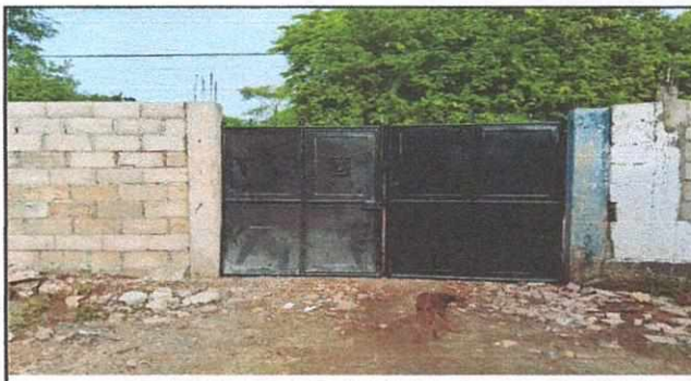
Foto 6 colocación de portón
