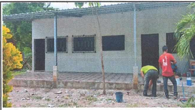
Foto 2 Trabajo finalizado de puertas y 2 balcones así como cernido y piso
