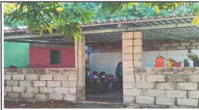
Foto 4 Trabajo finalizado de ampliación de galera, muro perimetral y malla y cambio de lámina
