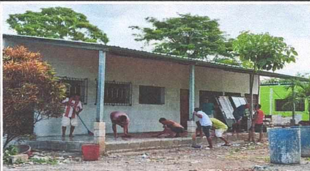
Foto 8 Proceso de puesta del piso del corredor
