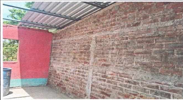
Foto 10 Cambio de lámina y arreglo de pared de la dirección.
