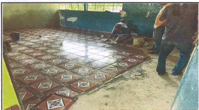
Foto 3: Colocación del piso cerámico por el de granito
