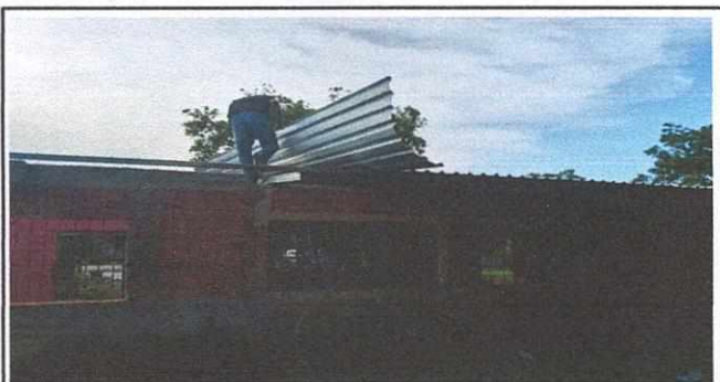
Foto 11 Cambio de lámina del techo del salon de primer grado
