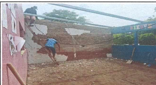
Foto 12 Arreglo de paredes, techo y torta del salon de primer grado
