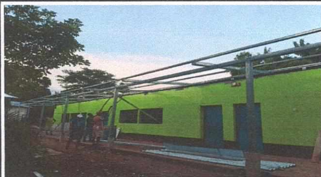
Foto 7 Proceso del cambio de techo del corredor
