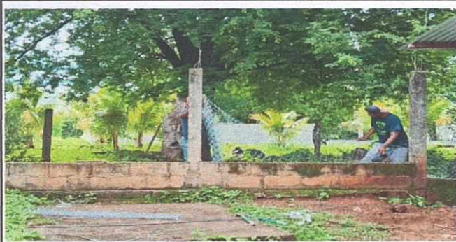
Foto 9 Cambio de malla dañada
