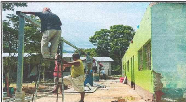
Foto1: cambio de techo
