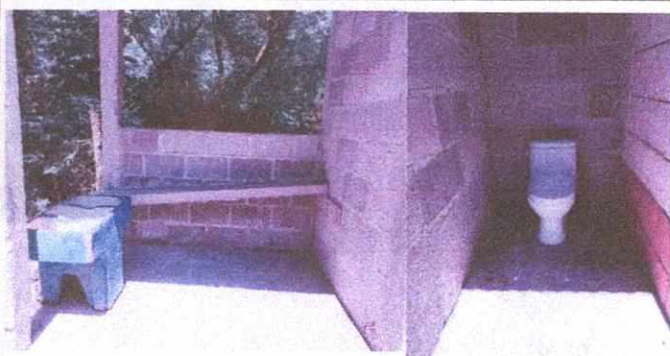
Foto 3: REPARACIÓN DE PAREDES Y PISO DE BAÑOS, SUSTITUCIÓN DE BAÑO
