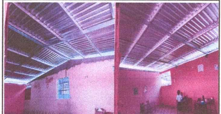
Foto 2: REMOZAMIENTO DE TECHO ESTRUCTURA Y LAMINA TROQUELADA
