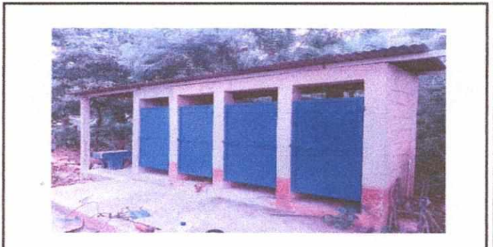
Foto 6: SUSTITUCION DE PUERTAS DE SANITARIOS
