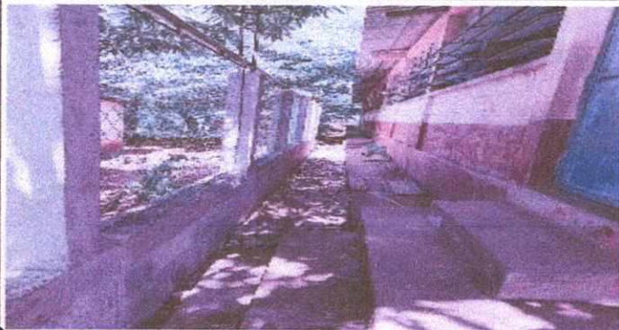
Foto 1: REMOZAMIENTO DEMURO DE CONTENCIÓN DE LADO DERECHO FINALIZADO
