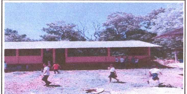
Foto 4: REMOZAMIENTO DE TECHO ESTRUCTURA Y LAMINA TROQUELADA
