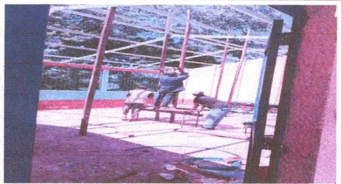
Foto 2: INICIO DE INTALACION DE ESTRUCTURA METALICA DE TECHO
