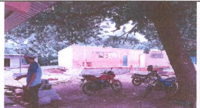
Foto 4: AVANCE DE TRABAJO EN GRADAS Y TECHO
