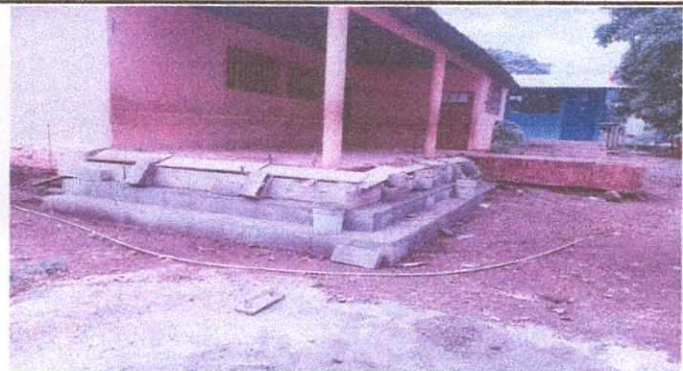
Foto 3: CONSTRUCCIÓN DE GRADAS Y MATENIMIENTO DE PASARELA
