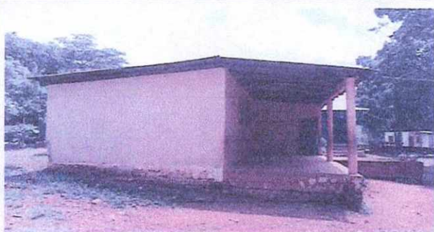
Sustitución de lámina troquelada
