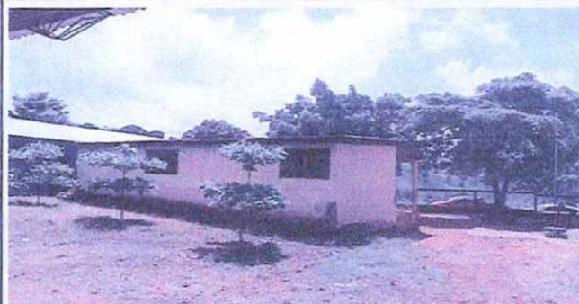
sustitución de estructura de madera por metal
