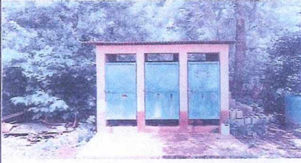
sustitución de puertas, y techo
