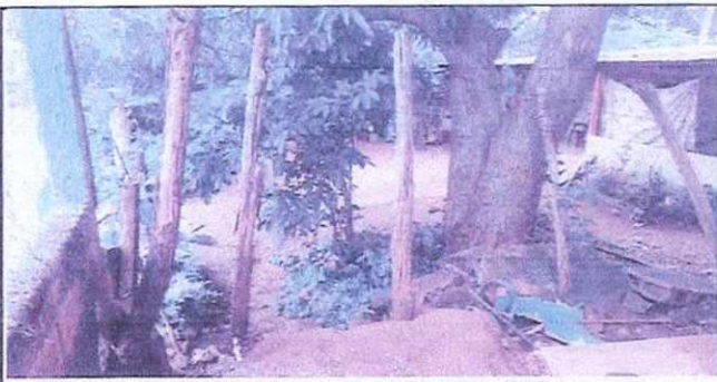
sustitución de muro perimetral
