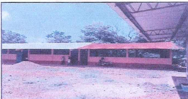
cambio de techo completo
