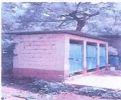
ampliación de un sanitario completo
