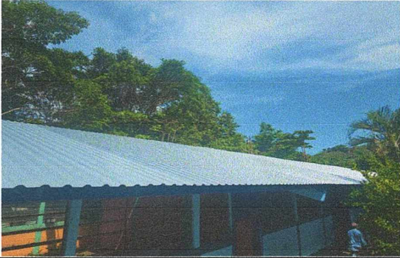
MÓDULO 1. SUSTITUCIÓN DE TECHADO
