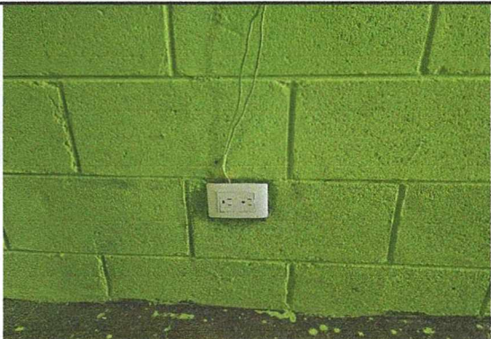
MÓDULO 3. REPARACIÓN ELECTRICA EXTERNA E INTERNA
