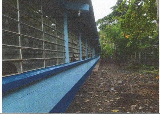
MÓDULO 2. PINTURA EXTERNA E INTERNA DE ESCUELA
