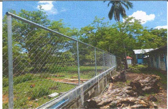
MÓDULO 4. REPARACIÓN DEL MURO PERIMETRAL
