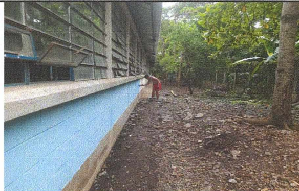
MÓDULO 2. PINTURA EXTERNA E INTERNA DE ESCUELA
