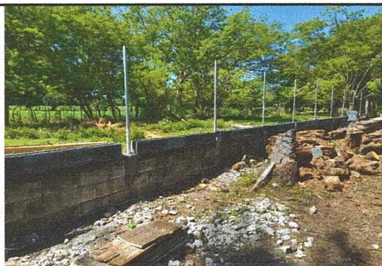
MÓDULO 4. REPARACIÓN DEL MURO PERIMETRAL
