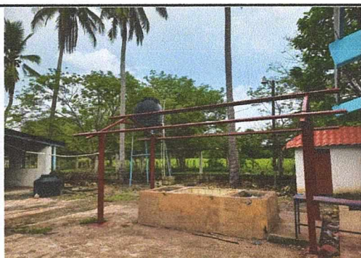
MÓDULO 5. REPARACIÓN DE GALERA DE PILA Y BASE DEL DEPÓSITO DE AGUA
