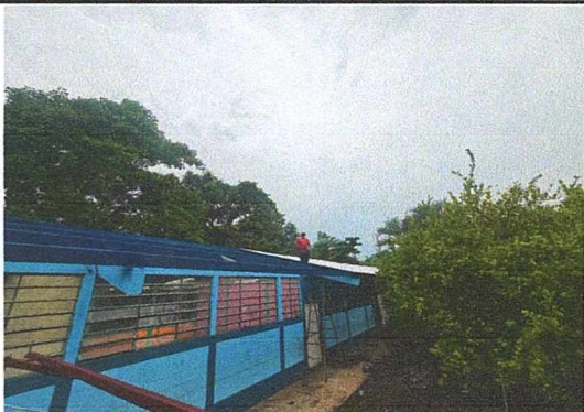
MÓDULO 1. SUSTITUCIÓN DE TECHADO
