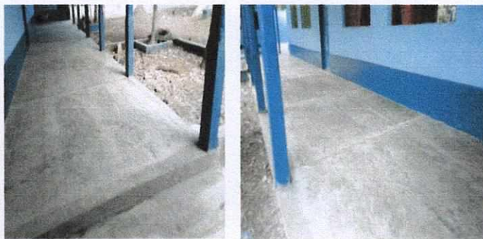
Módulo 1. Sustitución de piso
