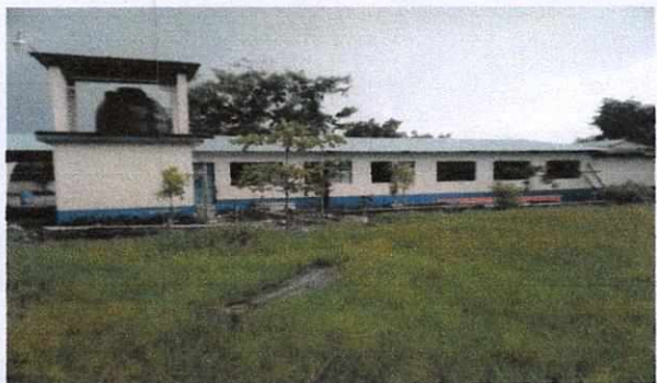
Módulo 1. Sustitución Techado
