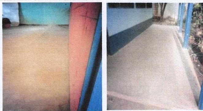
Módulo 2. Sustitución de piso
