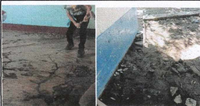
Módulo 2. Sustitución de piso
