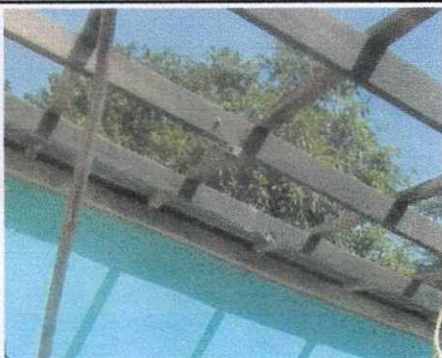
Módulo 1. Sustitución de Solera superior
