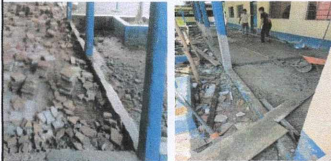
Módulo 1. Sustitución de piso
