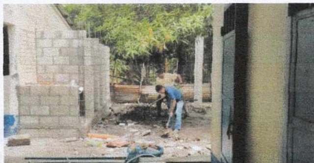
Módulo 3. Ampliación de Servicios Sanitarios
