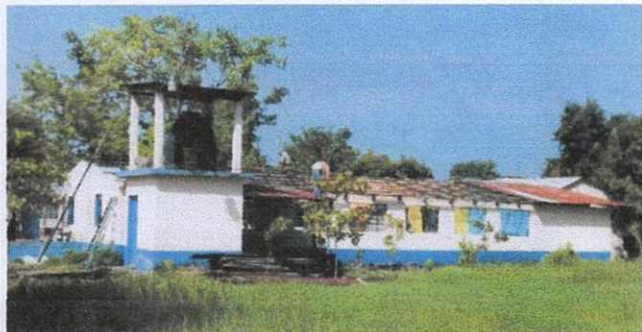
Módulo 1. Sustitución Techado
