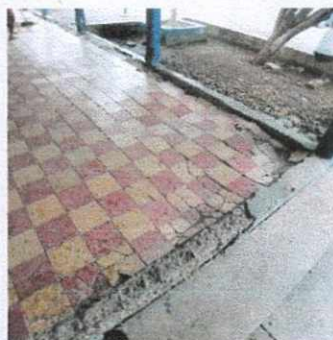
Módulo 1. SUSTITUCIÓN DE PISO
