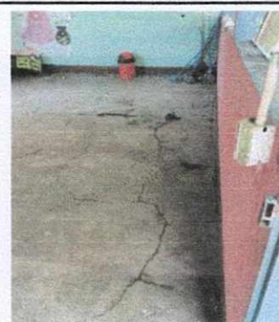
Módulo 2. SUSTITUCIÓN DE PISO
