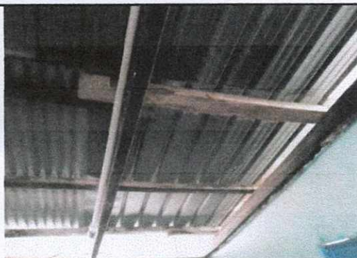
Módulo 1. SUSTITUCIÓN DE SOLERA SUPERIOR
