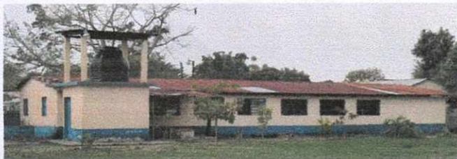
Módulo 1. SUSTITUCIÓN DE TECHADO
