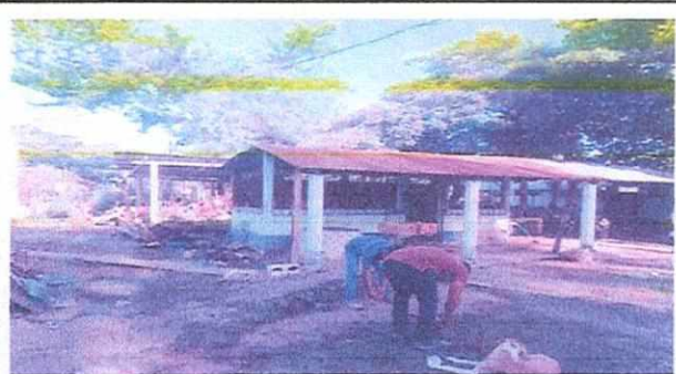
FOTO 2. SUSTITUCIÓN DE TECHO DE COCINA
