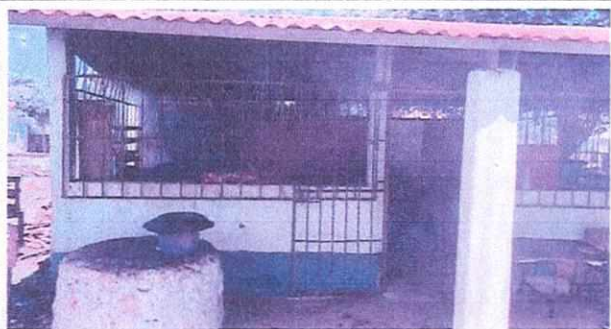
FOTO 6. SUSTITUCIÓN DE PUERTAS Y VENTANAS DE COCINA
