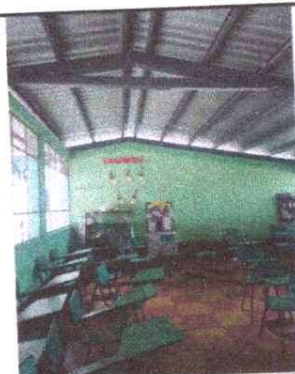
Foto 4: Finalización de mantenimiento de Estructura portante galvanizada modulo 2 al 100%
