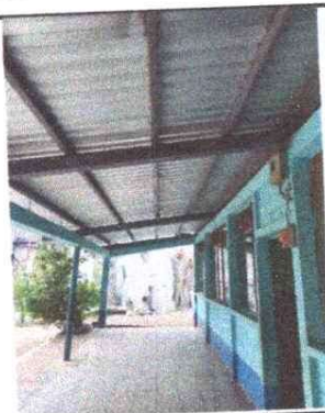
Foto 3: Finalización del trabajo de sustitución de techo de fibrocemento, por lámina troquelada calibre 26 modulo 2 al 100%
