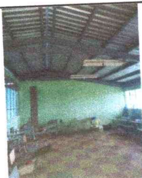
Foto 5: Finalización del trabajo de sustitución de techo de fibrocemento, por lámina troquelada calibre 26 y Mantenimiento de Estructura portante galvanizada modulo 3 al 100%
