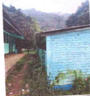
Foto 2: Finalización del trabajo de sustitución de lámina metálica, por lámina troquelada calibre 26 modulo 1 al 100%
