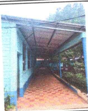
Foto 1: Finalización del trabajo de sustitución de madera, por estructura portante Galvanizada, modulo 1 al 100%
