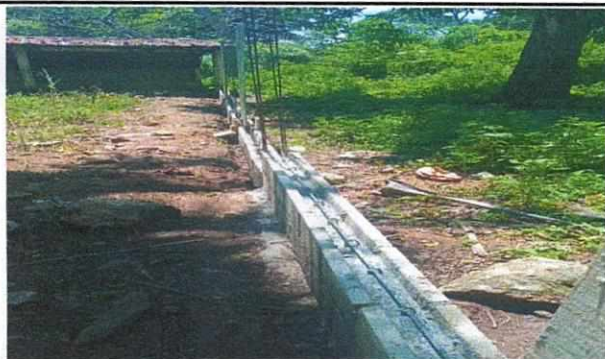
Foto 5: Avances en mejoramiento de muro perimetral con block (fundición de bases para colocación de malla metálica).
