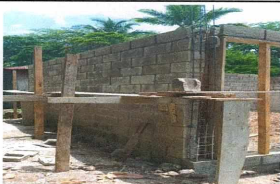
Foto 3: Preparación de pilares y de preparación de estructura de soporte.
