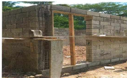
Foto 2: Area de cocina con paredes de block. Trabajos de reforzamiento de columnas en proceso.
