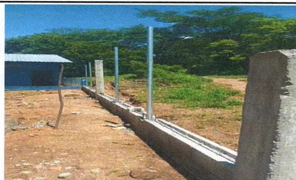
Foto 4: Mejoramiento de muro perimetral con block en proceso (retiro de malla dañada, fundición y colocación de tubo de soporte)
