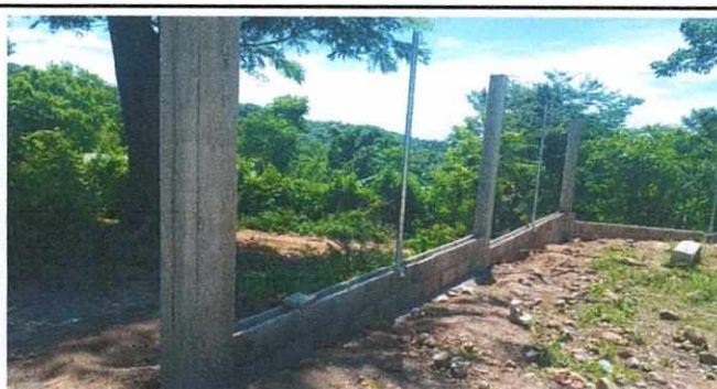
Foto 6: Reforzamiento de pilar de concreto para soporte de portón metálico finalizado.
