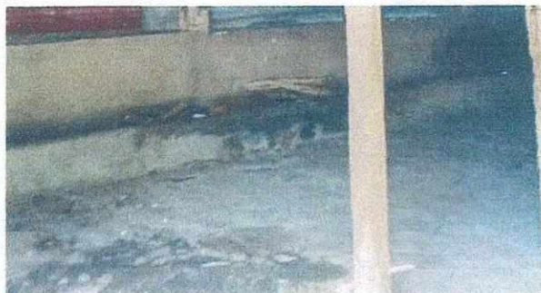
Foto 4: Mejoramiento de torta de cemento dañada a reparar/mejorar con torta lisa de cemento.
