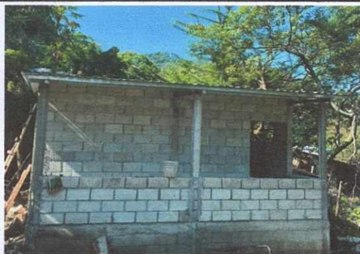
Foto 1: Remodelación de cocina terminada
