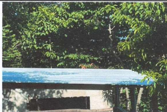
Foto 2: Techo totalmente renovado con estructura metálica y lámina troquelada calibre 26.
