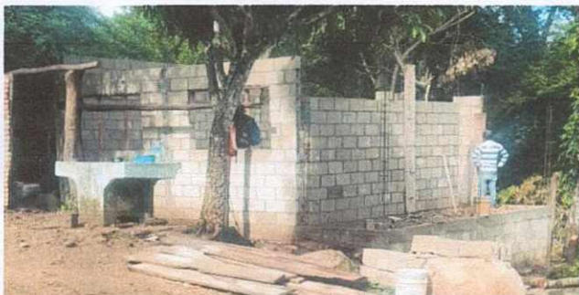
Foto1: Mejoramiento de las paredes de block.
