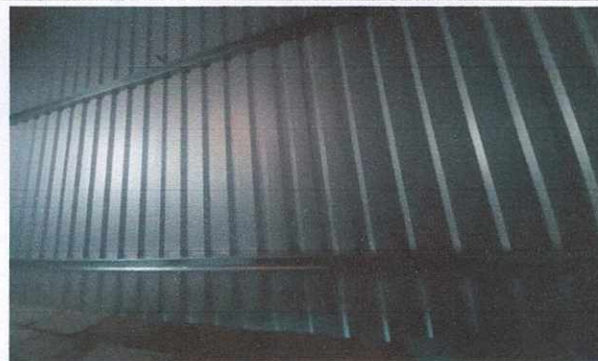
Foto 2: Sustitución del techo de la cocina.
