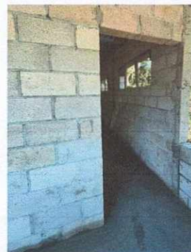
Foto 4: Sustitución de puerta de lámina, por puerta de metal.
