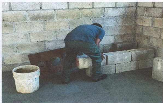
Foto 3: Remodelación e instalación de plancha para cocinar
