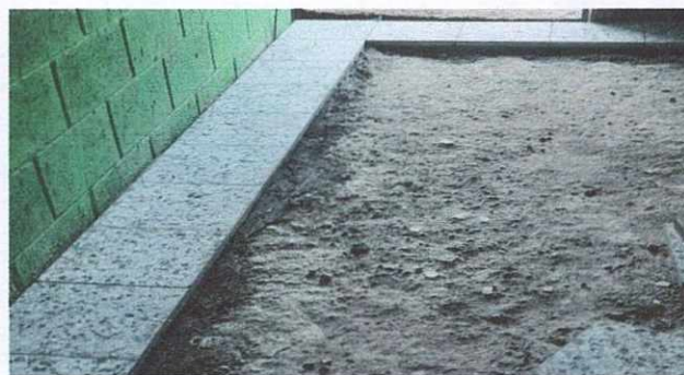
Foto 6: Colocación del piso de granito
