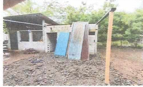
Foto 4: levantamiento y circulación de cocina con muro a tres hiladas, tubo galvanizado y malla.
