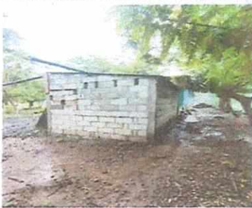
Foto 3: levantamiento de muro en cocina
