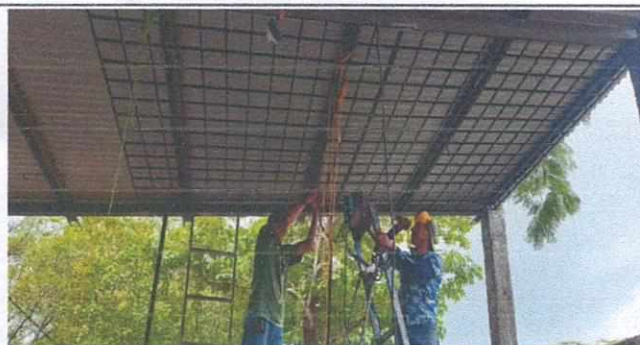
Foto 3: Mejoramiento estructura Soporte
