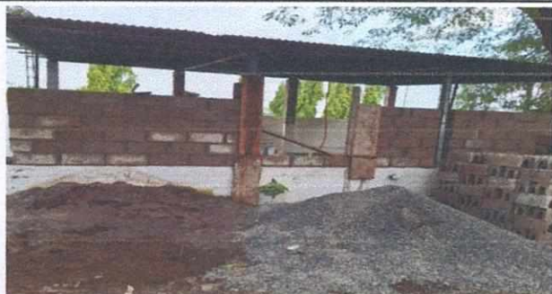
Foto 1: Mejoramiento de paredes
