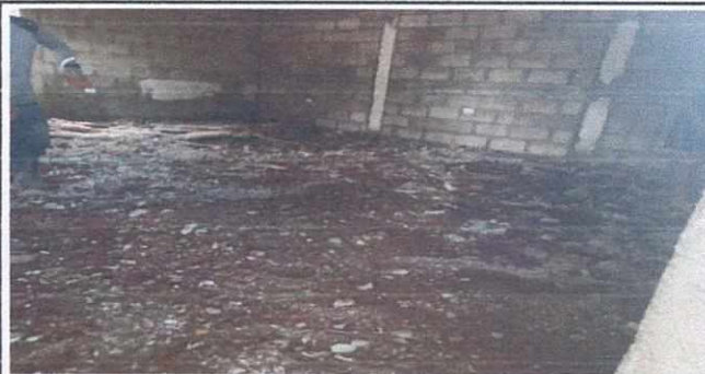
Foto 2: Mejoramiento de piso
