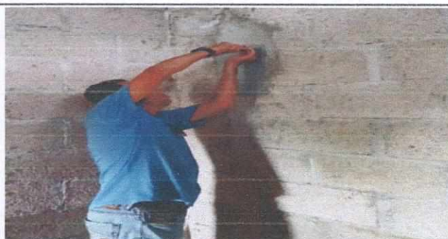
Foto 4: Mejoramiento Instalación Eléctrica
