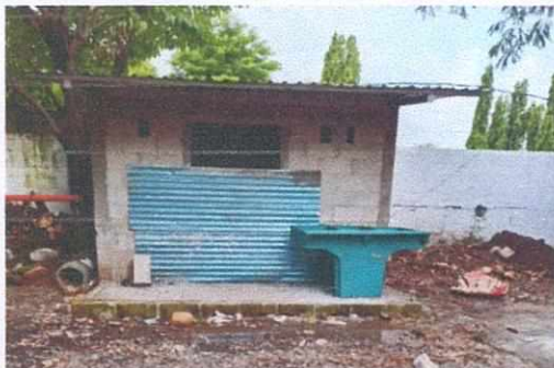
Foto 1: Mejoramiento de Paredes
