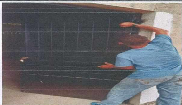
Foto 5: Mejoramiento de puerta
