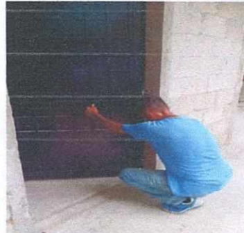
Foto 2: Mejoramiento de Puerta
