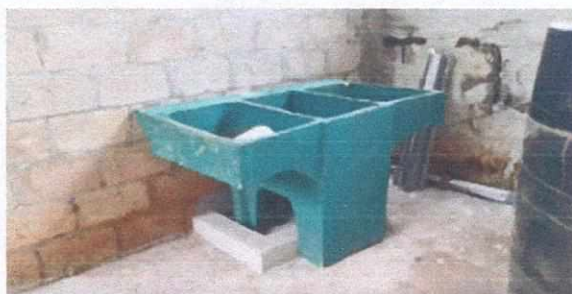
Foto 5: Sustitución de Pila
