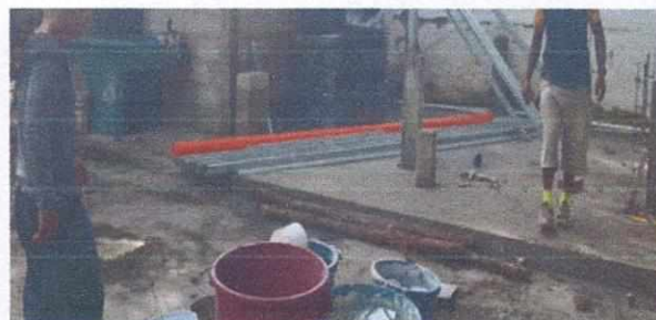
Foto 4: Mejoramiento de piso galera para cocina
