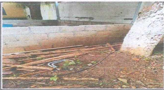
Foto 5: Sustitución de pila
