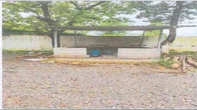
Foto 1: Mejoramiento de paredes
