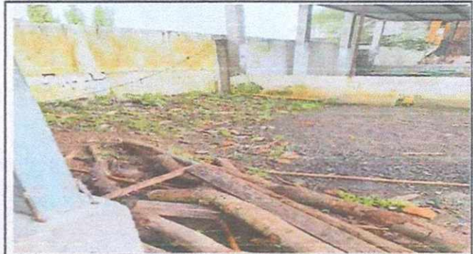
Foto 4: Mejoramiento de piso galera para cocina
