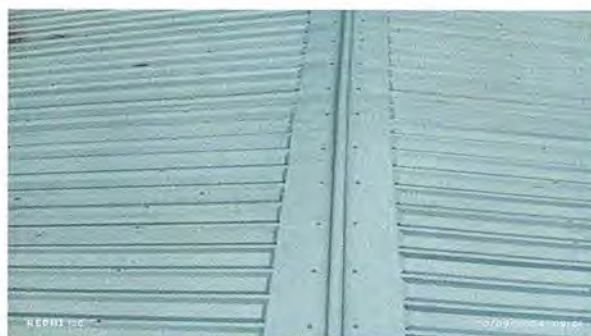
Foto 2: Sustitución de lámina dañada con lámina troquelada calibre 26 y sustitución de estructura dañada con estructura portante galvanizada en techo de cocina concluidos.
