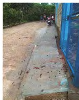
Foto 10: Mejoramiento de banqueta de concreta en area externa de edificio escolar.
