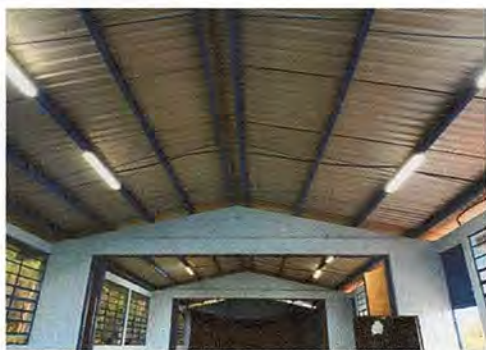
Foto 9: Sustitución/repelación de red y sumistros electricos en dirección
