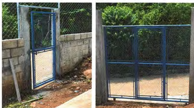
Foto 8: Trabajos de mejoramiento de portón de acceso principal y puertas de acceso peatonal concluidos.
