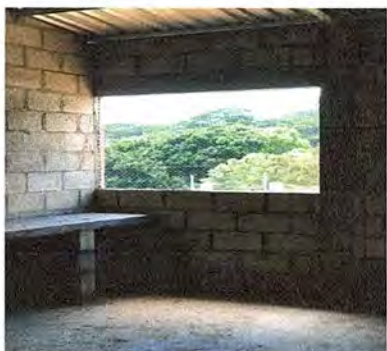
Foto 7: Mejoramiento de torta de cemento, mesa de cemento y colocación de malla en ventana de cocina finalizado.
