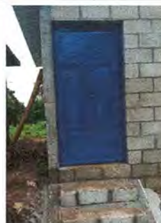
Foto 6: Sustitución de puerta dañada por puerta metálica en cocina completada.
