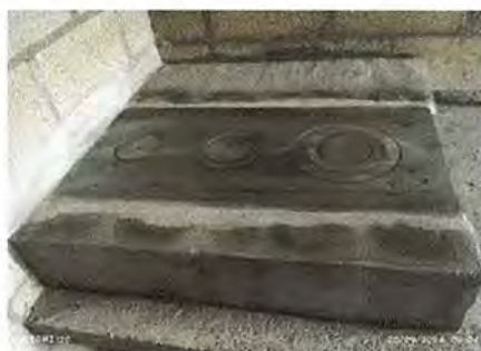
Foto 4: Reparación de polletón con block y concreto con plancha metálica de tres hornillas y chimenea con tubos de concreto concluido.
