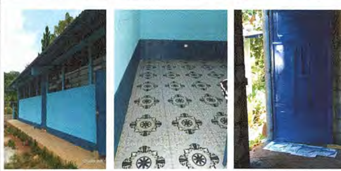
Foto 12: Paredes de aulas pintadas, colocación de piso ceramico y mantenimiento de puerta metálica en instalaciones de dirección del establecimiento.
