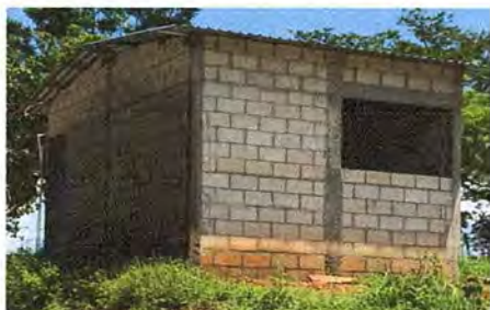
Foto1: Trabajos de mejoramiento de paredes de block en cocina culminados
