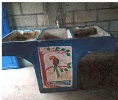
Foto 11: Colocación de pila de cemento prefabricada en cocina concluido.
