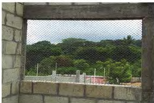
Foto 3: Trabajos completados de colocación de malla metálica en ventanas de cocina
