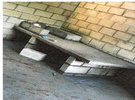
Foto 4: Reparación de polletón con block y concreto en proceso.
