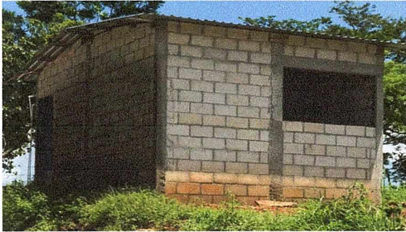
Foto1: Trabajos de mejoramiento de paredes de block en finalizados (Reforzamiento de cimientos y columnas incluidos)
