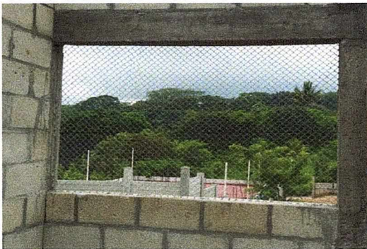
Foto 3: Ventanas con malla metálica para ventilación en cocina en proceso.
