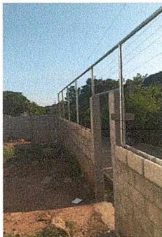
Foto 5: Trabajos de mejoramiento de muro perimetral con de malla metálica por terminarse.
