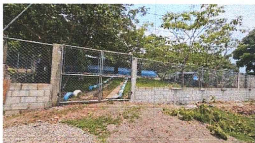
Foto 5: FINALIZACION MEJORAMIENTO MURO PERIMETRAL BLOCK Y MALLA LADO ENFRENTA CON SU PORTON
