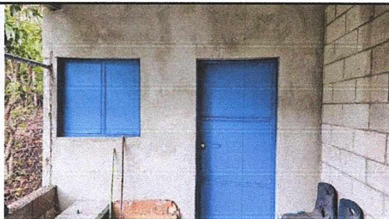
Foto 1: FINALIZACION MEJORAMIENTO DE AREA DE COCINA CON SU PUERTA Y VENTANA
