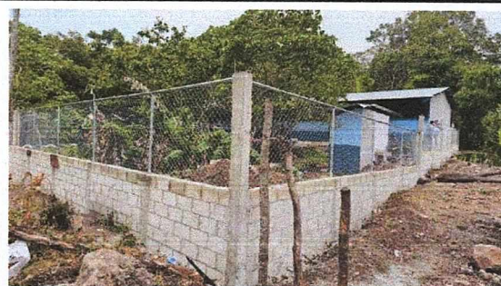
Foto 4: FINALIZACION MEJORAMIENTO MURO PERIMETRAL BLOCK Y MALLA LADO IZQUIERDO
