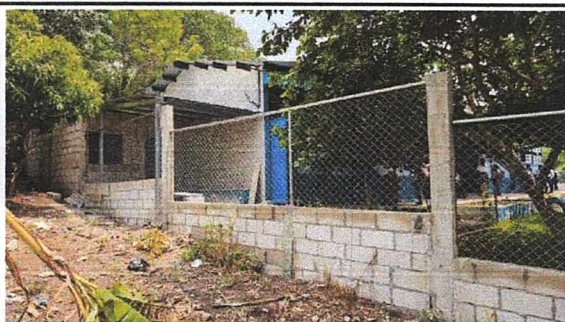
Foto 3: FINALIZACION MEJORAMIENTO MURO PERIMETRAL BLOCK Y MALLA LADO DERECHO
