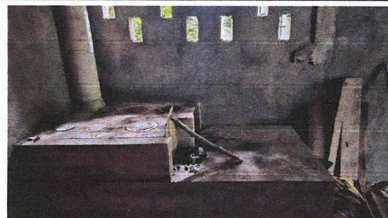
Foto 2: FINALIZACION MEJORAMIENTO DE AREA DE COCINA CON SU POLLETON E INSTALACION ELECTRICA
