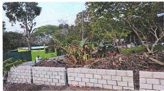
Foto 4: MEJORAMIENTO MURO PERIMETRAL LADO IZQUIERDO
