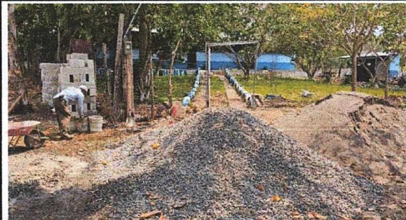
Foto 2: MEJORAMIENTO MURO PERIMETRAL PARTE DE ENFRETE
