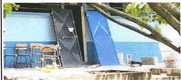
Foto 6: SUSTITUCION DOS CHAPAS
