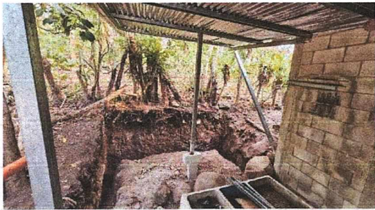
Foto 1: MEJORAMIENTO DE AREA DE COCINA
