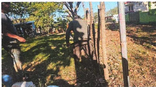
Foto 3: MEJORAMIENTO MURO PERIMETRAL LADO DERCHO
