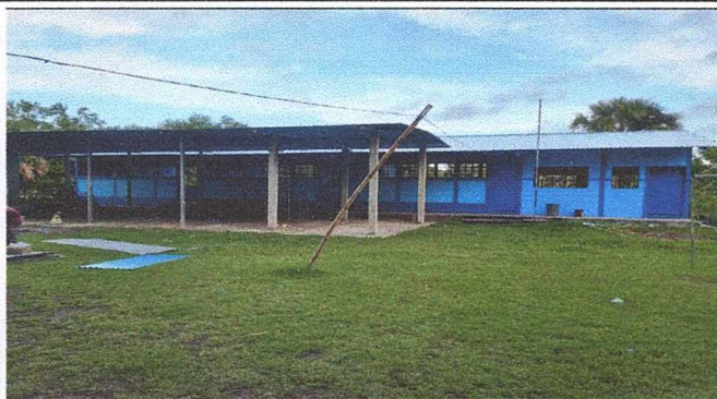
Foto1: CAMBIO DE TECHADO COMPLETO
