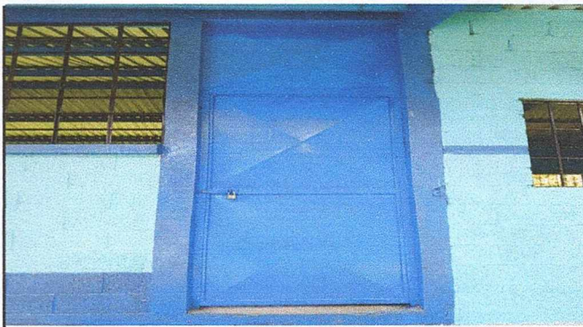
Foto 4: SUSTITUCIÓN DE PUERTAS DE METAL
