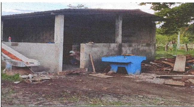
Foto 6: SUSTITUCION DE TORTA DE COCINA
