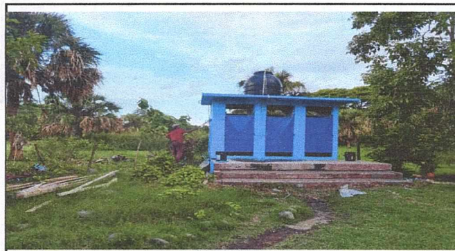
Foto 3: PINTURA DE SANITARIOS
