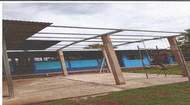
Foto 1: CAMBIO DE TECHADO DE GALERA DEL ESCENARIO
