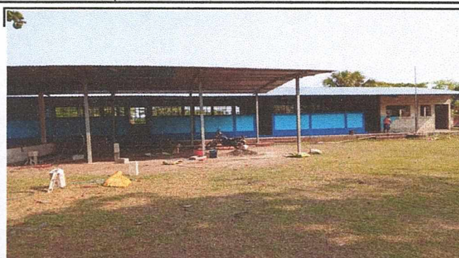
Foto 2: CAMBIO DE PINTURA Y TECHADO
