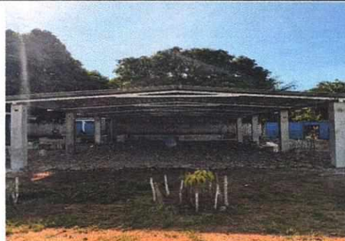
Foto 2: GALERA CON SU RESPECTIVO ESCENARIO SUSTITUCION DE ESTRUCTURA METALICA, SUSTITUCION DE TECHO, ELABORACION DE ESCENARIO, REPELLO DE PARED Y PILARES DE CEMENTO
