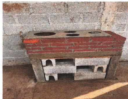
Foto 6: SUSTITUCION DE PLANCHA DE CEMENTO POR ESTUFA RURAL.
