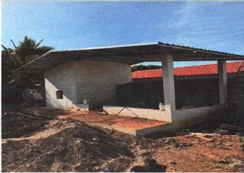
Foto 1: COCINA, AMPLIACION DE PAREDES, SUSTITUCION DE TECHO, SUSTITUCION DE ESTRUCTURA METALICA, REPELLO DE PAREDES, ELABORACION DE PISO DE CEMENTO.
