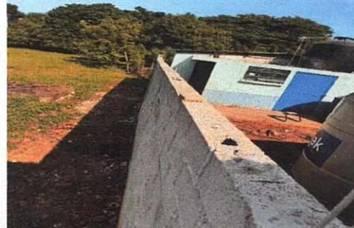
Foto 4: TERMINACIÓN DE MURO PERIMETRAL SUR. AMPLIACION DE PARED DE BLOCK.
