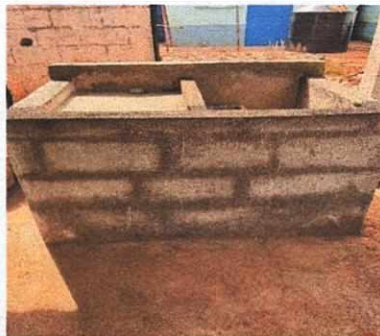
Foto 5: PILA DE CONCRETO. SUSTITUCION DE PILA DE CEMENTO POR PILA FABRICADA DE BLOCK.
