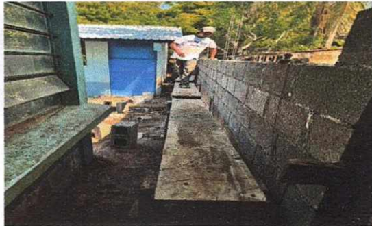
Foto 3: TERMINACIÓN DE MURO PERIMETRAL NORTE AMPLICACION DE PARED DE BLOCK, CEMENTO, ARENA, PIEDRIN, HIERRO.
