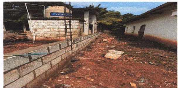
Foto 4: TERMINACION DE MURO PERIMETRAL SUR, AMPLICACION DE PARED DE BLOCK, HIERRO, CEMENTO, ARENA, PIEDRIN,
