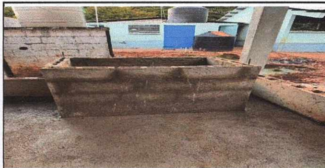
Foto 5: PILA DE CONCRETO, ELABORADA CON CEMENTO, HIERRO Y BLOCK
