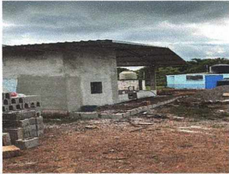
Foto 1: COCINA, SUSTITUCION DE TECHO, AMPLIACIÓN DE PAREDES, SUSTITUCIÓN DE ESTRUCTURA METALICA, AMPLIACION DE PAREDES, REPELLO DE PAREDES, PISOS DE CEMENTO
