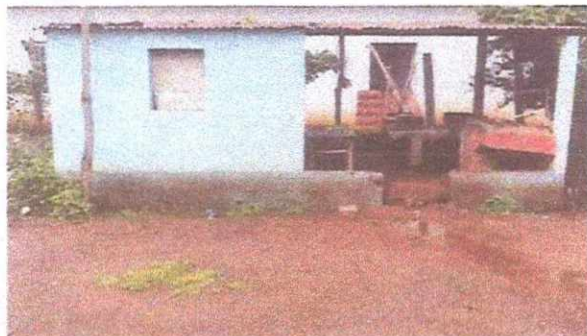
FOTO 1 Levantado de paredes, sustitución de techo.
