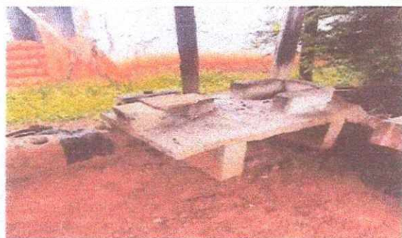
Foto 5 Sustitución de Plancha, por una Plancha Rural.
