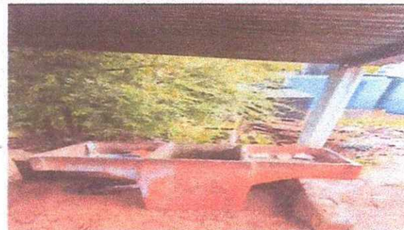
Foto 6. Sustitución de Pila, por una Pila de Cemento con Plancha.
