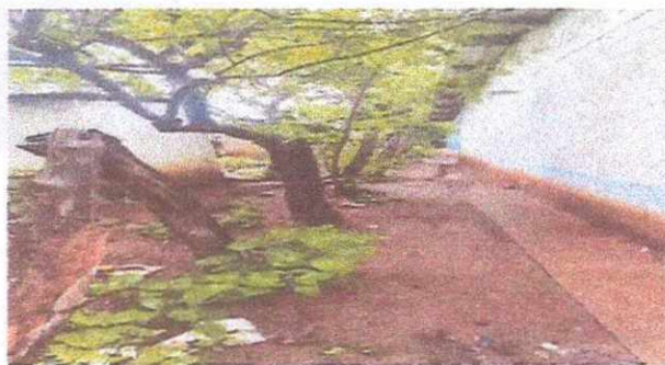
Foto 3 Ampliación de Muro Perimetral con Pared de Block.
