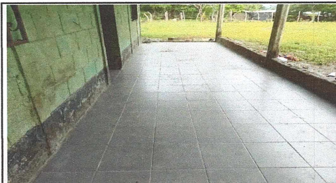
Foto 3: Colocacion de piso ceramico en aula y corredor finalizado.
