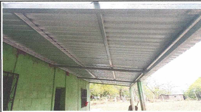
Foto 2: Colocacion de estructura metalica galvanizada, aula y corredor finalizada en su totalidad.
