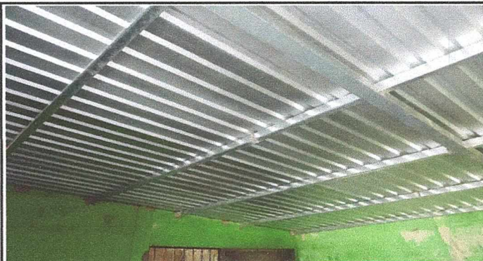
Foto 1: Colocacion de lamina metalica calibre 26 en aula, cocina y baños finalizado.
