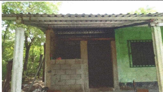
Foto 8: Mejoramiento de cocina completado (paredes, piso y techo.)
