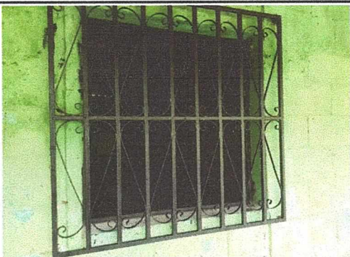
Foto 5: Colocacion de (4) ventanas de aula completado.
