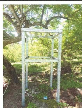
Foto 6: Colocacion de base para tinaco 1,200 litros finalizada.
