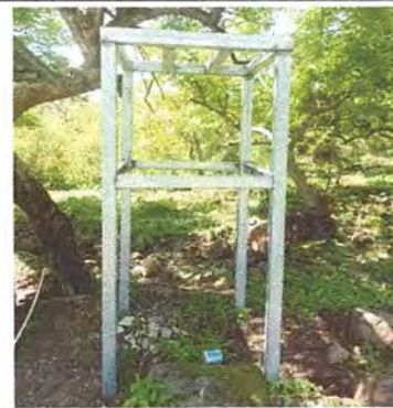
Foto 8: Realizacion de base para tinaco 1,200 litros.
