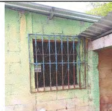
Foto 6: Sustitucion de ventanas, por ventanas de estructura de metal. Fase retiro de marcos dañados.
