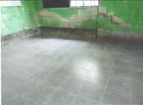
Foto 7: Avances en colocacion de piso ceramico nuevo.
