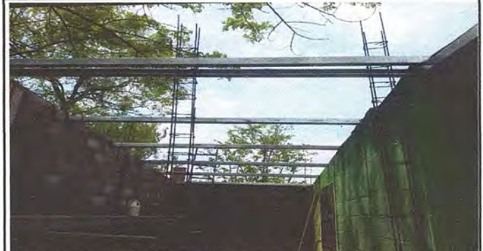
Foto 2: Mejoramiento de pared de block y techo en cocina en ejecucion.
