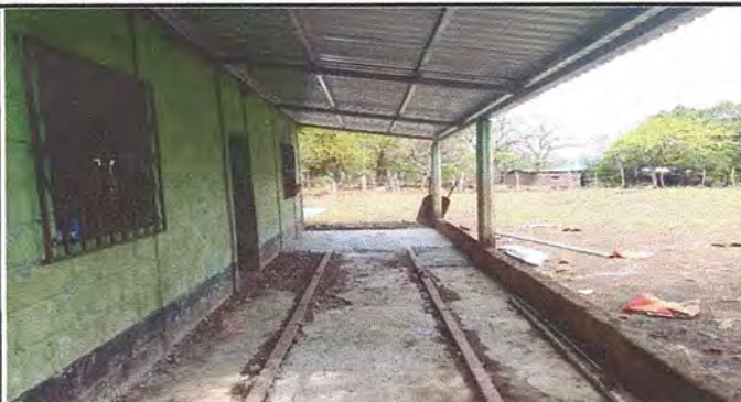
Foto 3: Sustitucion de torta de cemento por piso ceramico en corredor en proceso
