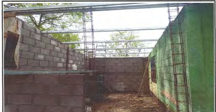
Foto 4: Sustitucion de estructura de soporte de madera, por estructura portante metalica galvanizada en proceso.
