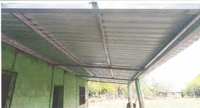
Foto 1: Sustitucion de lamina dañada por lamina troquelada calibre 26 en aula Y corredor.
