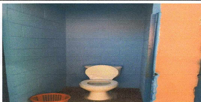
Foto 3: Pintura en paredes
