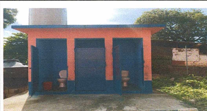
Foto 4: Cambio de tres sanitarios
