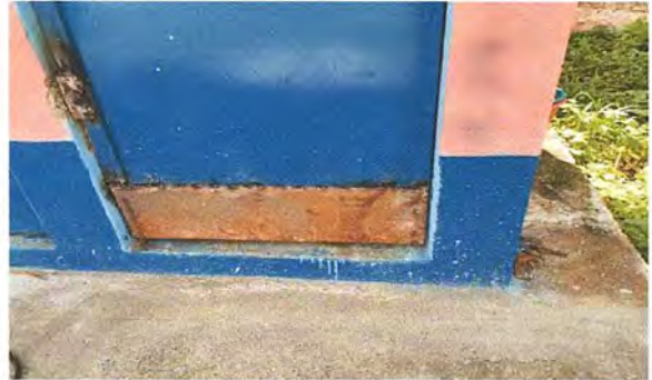
Foto 2: Aplicación de pintura anticorrosiva
