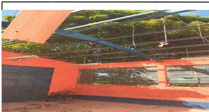
Foto 2: Aplicación de pintura anticorrosiva
