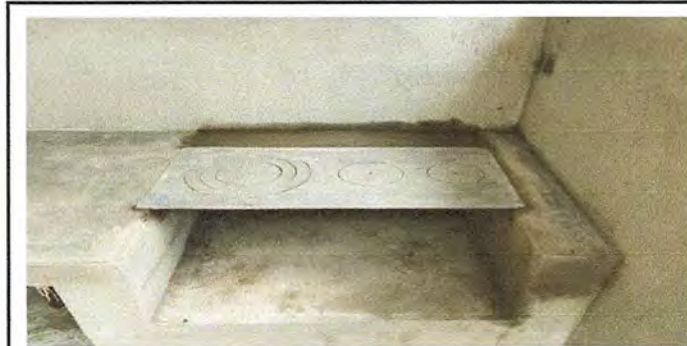
Foto 6: Colocación de estufa
