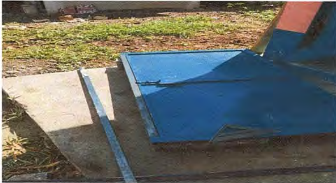
Foto 1: Cambio de marco en puertas de sanitarios
