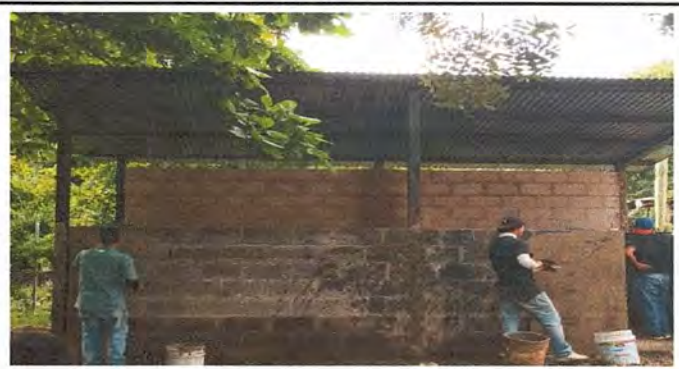
Foto 4: Levantado de muros de cocina
