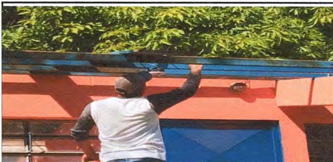
Foto1: Remozamiento de estructura metalica
