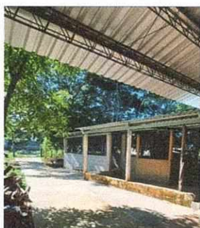
Foto 5: Sustitución de pilares de madera por pilares de concreto realizado.
