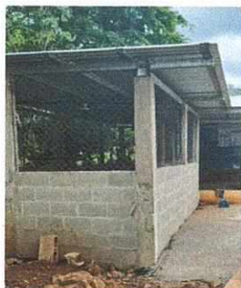
Foto 1: Mejoramiento de paredes de block en cocina terminado. Sutiución de estructura portante y lámina dañada finalizada.
