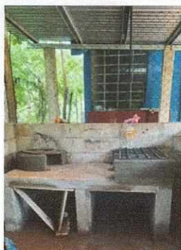
Foto 3: Finalizacion de trabajos de mejoramiento de polletón en etapa de revestimiento con cemento
