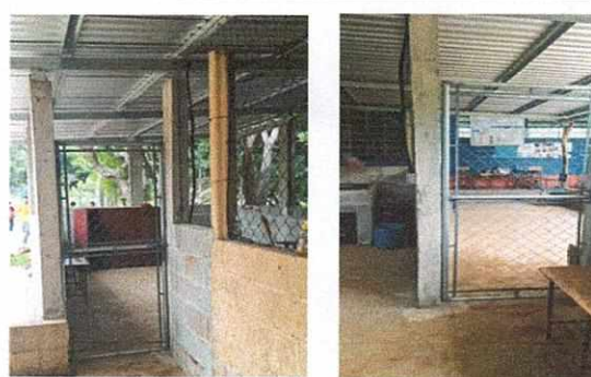
Foto 6: Instalación terminada de puerta de metal en cocina y sustitución de pilares de madera por pilares de concreto
