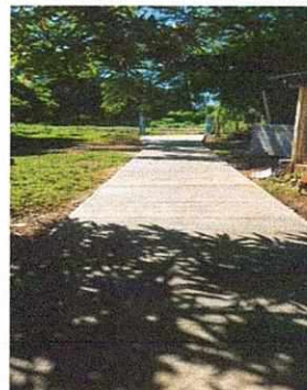
Foto 10: Trabajos de mejoramiento de entrada principal con concreto completados.
