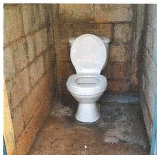
Foto 7: Instalación de sanitario lavable de cerámica con accesorios. Culminado.
