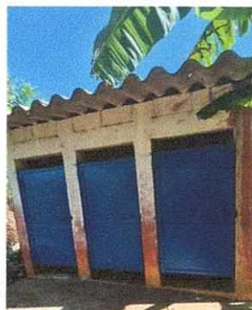
Foto 8: Trabajos finalizados de reparación de puertas metálicas de sanitarios.
