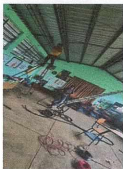
Foto 9: Finalización de trabajos de reparación del sistema eléctrico en aulas.
