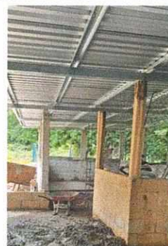
Foto 4: Sustitución de estructura portante de madera en mal estado por estructura metálica galvanizada en cocina (trabajos completados)
