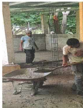
Foto 2: Mejoramiento de torta lisa en cocina en proceso
