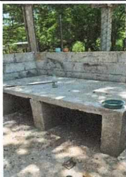
Foto 5: Avances en los trabajos de sustitución de pilares de madera por pilares de concreto en cocina.
