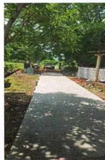
Foto 6: Mejoramiento de entrada principal con plancha de concreto terminado
