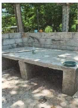
Foto 3: Mejoramiento de poltón en etapa de revestimiento con cemento
