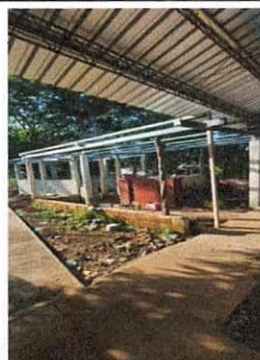
Foto 4: Sustitución de estructura portante de madera en mal estado por estructura metálica galvanizada en cocina por culminarse.
