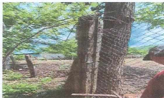
Foto 14: Remodelación de pilares de muro perimetral en mal estado
