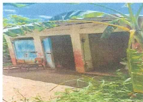
Foto 10: Área de reparación e instalación de tubería de drenaje
