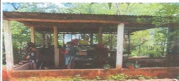
Foto 6: Cambio de lámina de cocina deteriorada a lámina troquelada calibre 26
