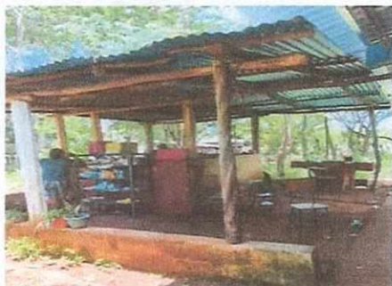
Foto 7: Sustrucción de pilares de madera por pilares de concreto de 20*20
