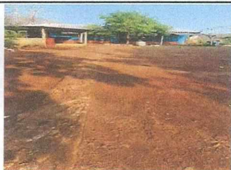
Foto 15: Reparación y modificación de entrada principal a planchas de concreto
