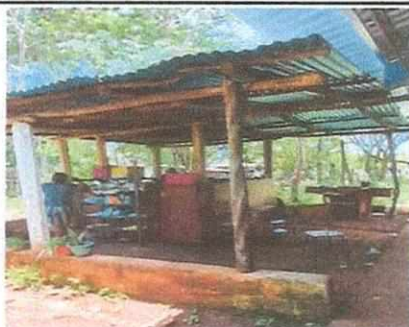
Foto 5: Techo de cocina de madera dañado a sustituir por estructura metálica galvanizada
