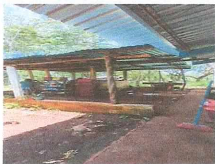
Foto 1: Ampliación y modificación de cocina (paredes)
